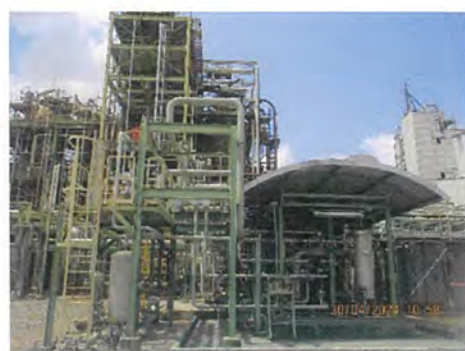
ภาพที่ 2-6 หน่วยนำกลับไอสารไฮโดรคาร์บอน (VOC Recovery Unit: VRU) ของโรงงานที่ 2 (ใช้ร่วมกับ PP2)
