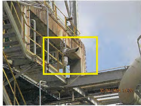
ภาพที่ 2-28 Safety Relief Valve
