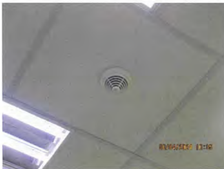
ภาพที่ 2-23 Smoke Detector
