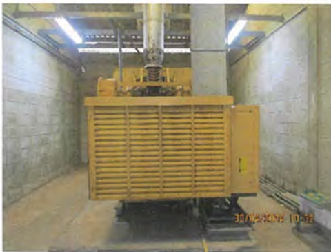
ภาพที่ 2-33 Diesel Generator
