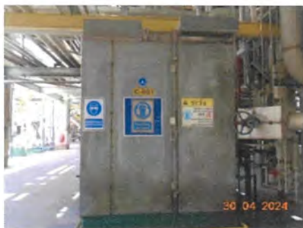
ภาพที่ 2-13 กล่องครอบลดเสียงดังจากเครื่องจักรและปั๊มเตือนให้สวมใส่อุปกรณ์ป้องกันเสียงดัง
