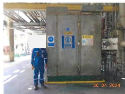
ภาพที่ 2-13 กล่องครอบลดเสียงดังจากเครื่องจักรและปั๊มเตือนให้สวมใส่อุปกรณ์ป้องกันเสียงดัง
