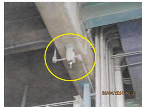
ภาพที่ 2-24 Heat Detector
