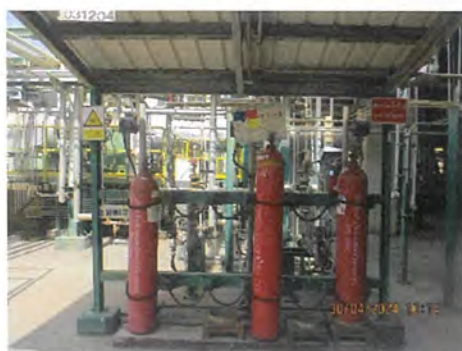
ภาพที่ 2-5 ถังก๊าซ CO เพื่อใช้ในระบบ CO Injection
